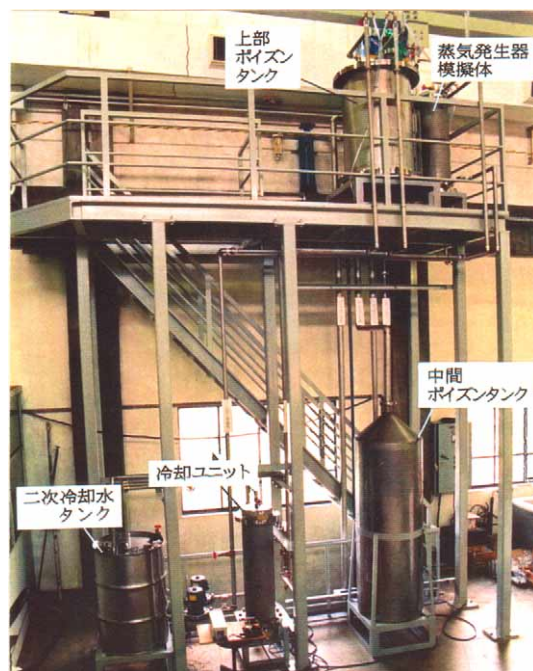
図3. 完成した装置の外観(2階部分)
