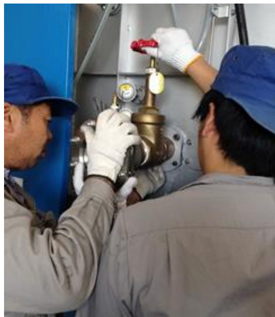
図6 ヒーター交換修理の様子
