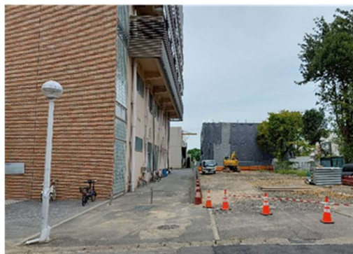
図 7. 実験実習工場 跡地
